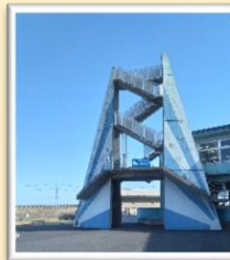
震災遺構 請戸小学校
