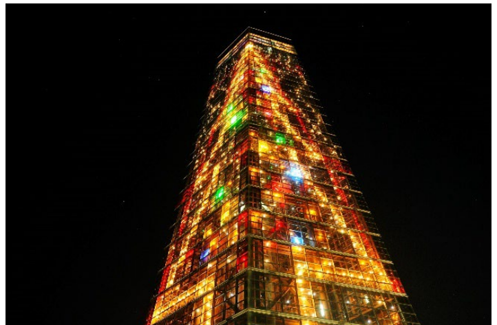
千葉ポートタワークリスマスファンタジー2023
