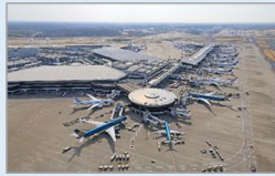
【成田空港制限区域】 制限エリアの視察
