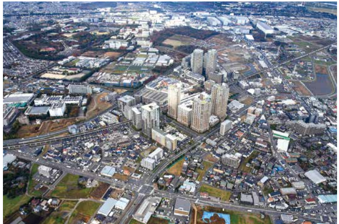
柏の葉（かしのは）スマートシティ全景（柏市役所提供）
